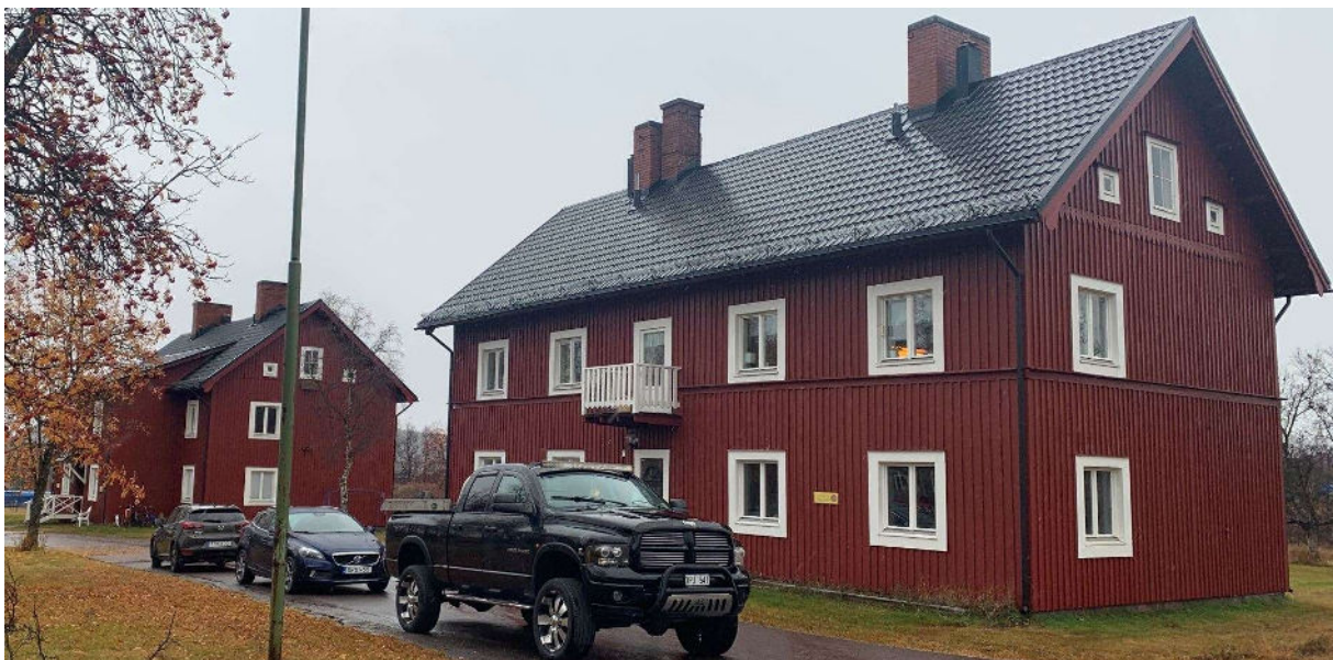
Bild 1. Lokstallsområdet, exempel på byggnader
