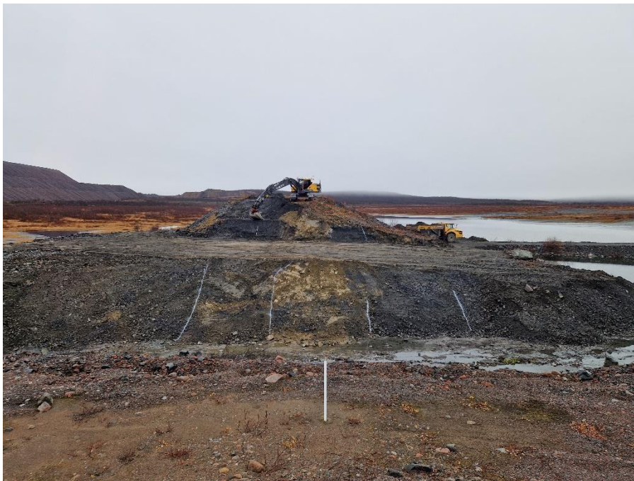
Figur 2 Framschaktat tvärsnitt med vita markeringar vid materialövergångar.
